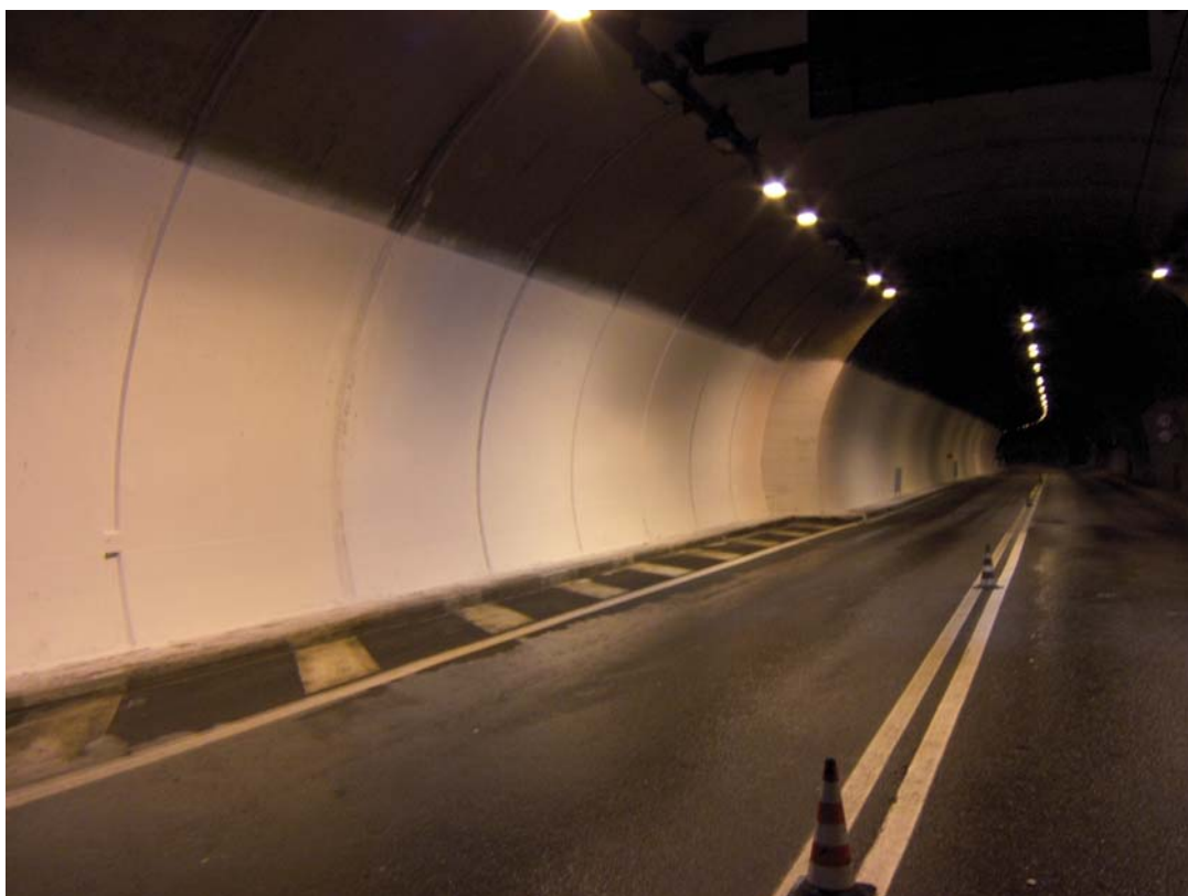
Esecuzione di imbiancatura galleria già in esercizio
