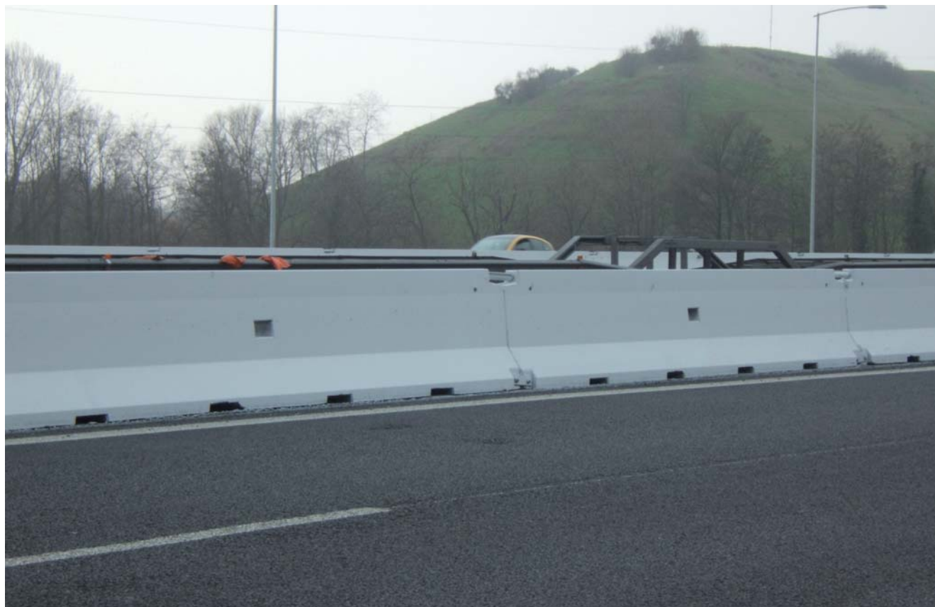
Esecuzione di imbiancatura new jersey con vernice fotocatalitica
