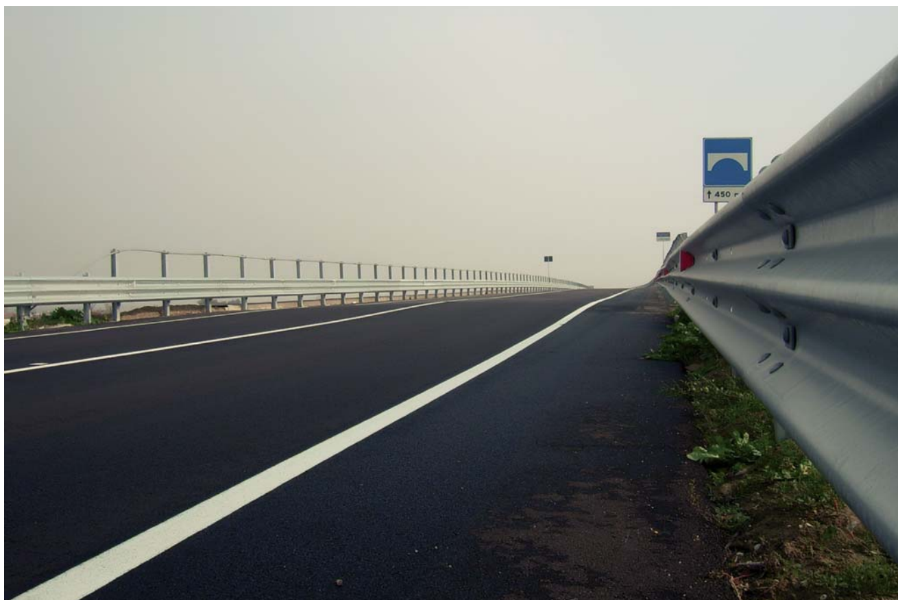
Realizzazione di posa in opera di barriere stradali su opera d'arte
