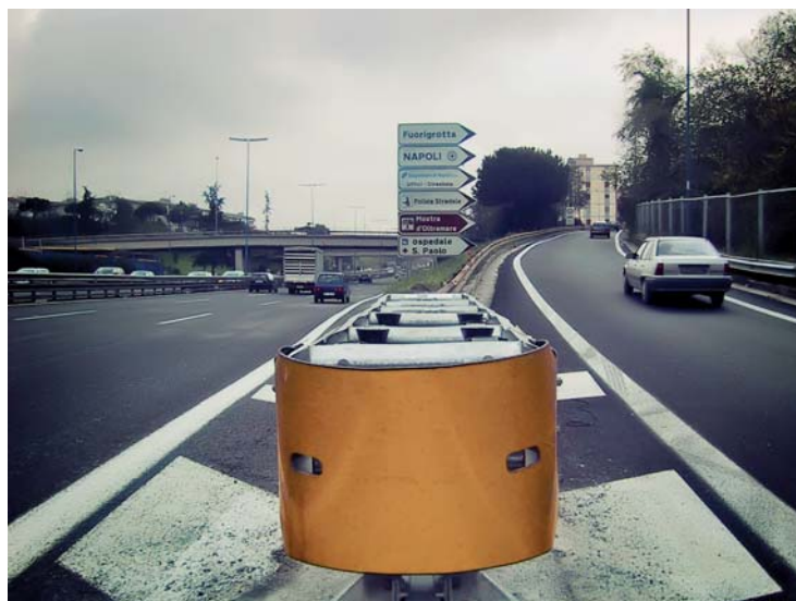
Realizzazione di posa in opera di assorbitori d'urto del tipo redirettivo
