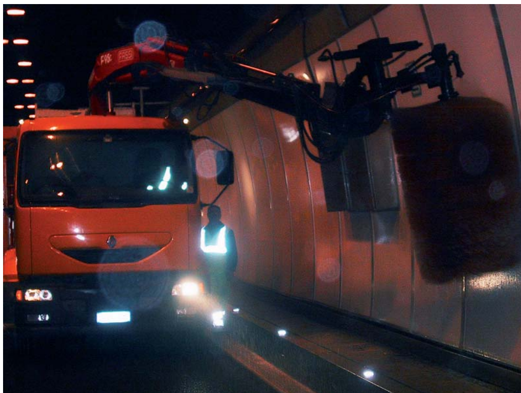
Mezzo operativo al lavoro per il rotolavaggio di pannelli di rivestimento galleria
