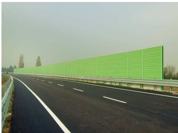
Realizzazione di posa in opera di barriere stradali fonoassorbenti
