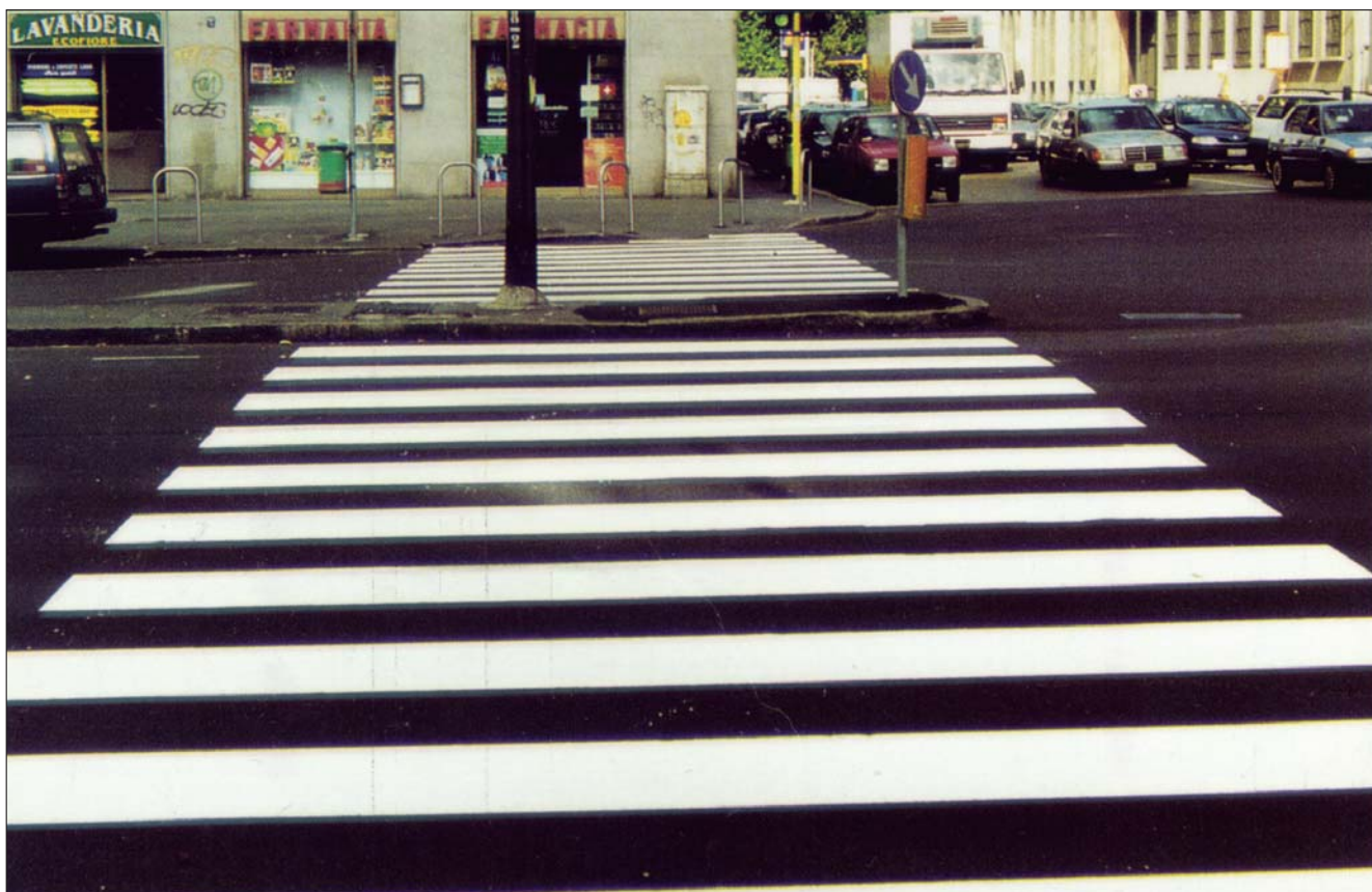
Realizzazione di passaggio pedonale tradizionale
