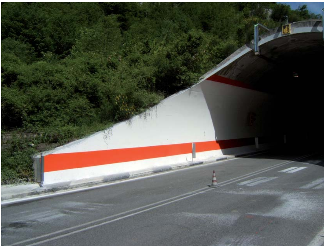
Esecuzione di imbiancatura galleria con fasce rosse all'imbocco
