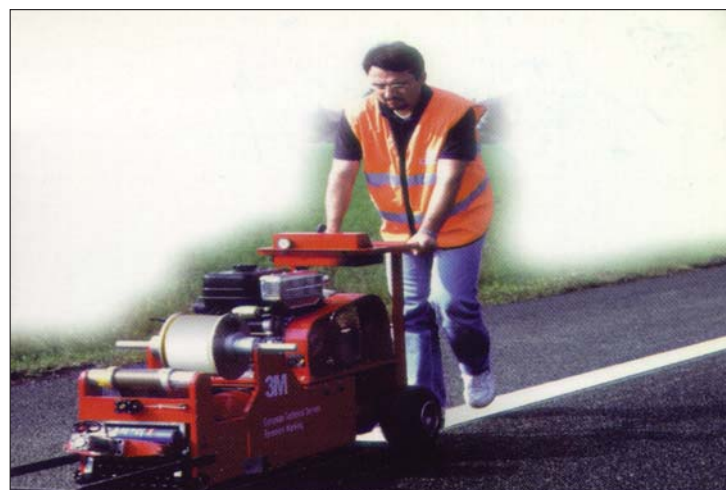
Posa in opera di laminato elastoplastico
