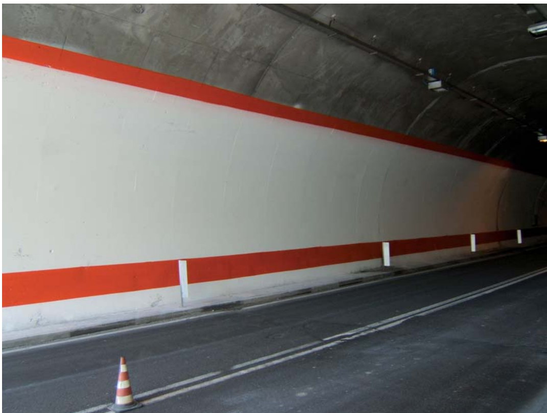
Esecuzione di imbiancatura galleria con fasce rosse longitudinali
