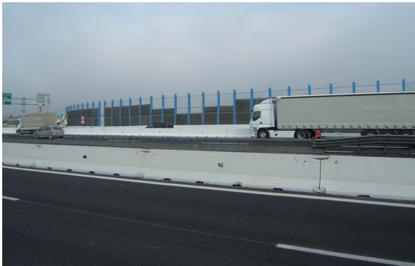
Esecuzione di imbiancatura new jersey con vernice fotocatalitica
