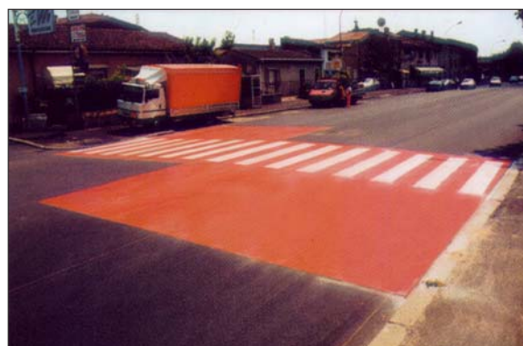
Realizzazione di passaggio pedonale colorato
