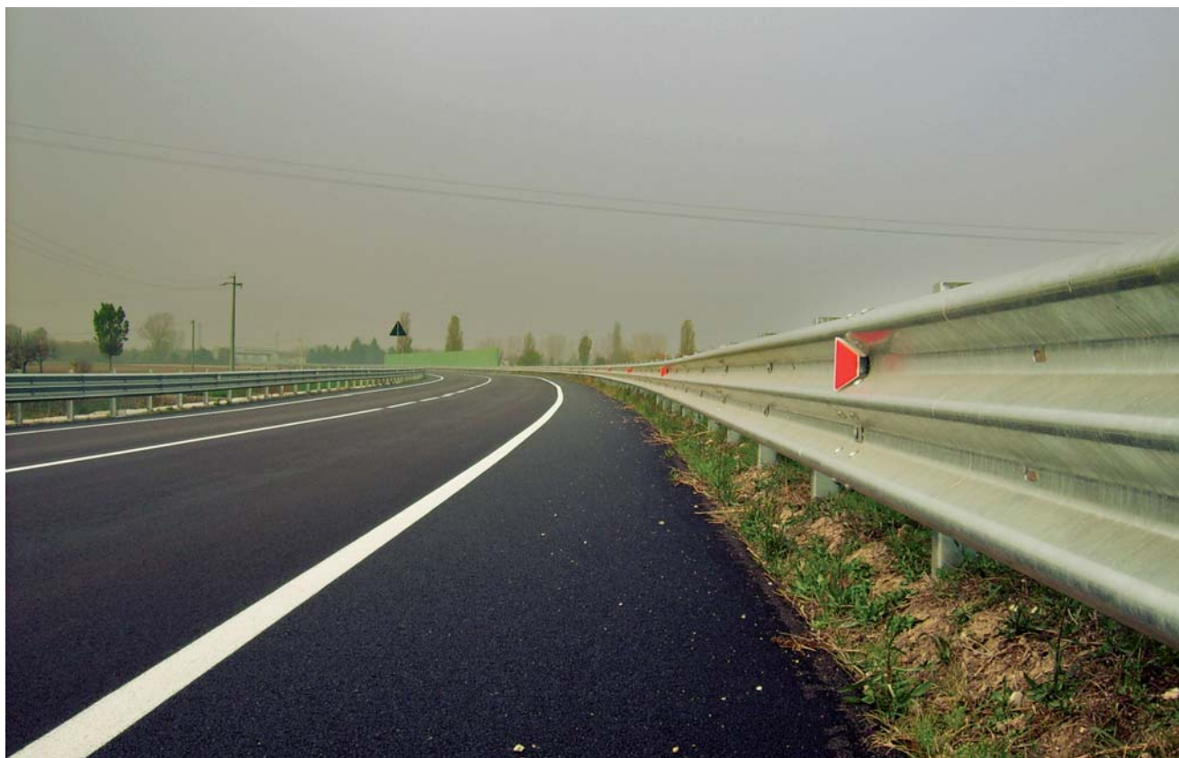
Realizzazione di posa in opera di barriere stradali su rilevato
