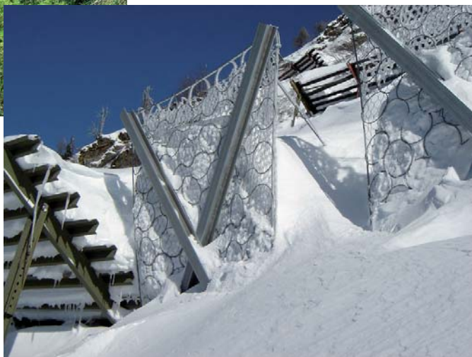
Realizzazione di posa in opera di barriera paramassi
