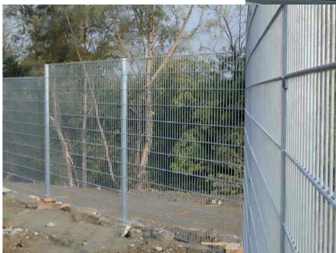
Realizzazione di posa in opera di rete di recinzione su rilevato
