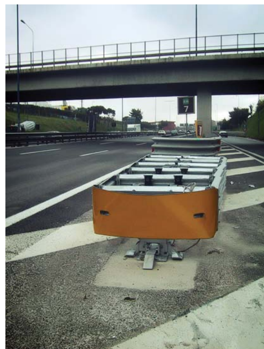
Realizzazione di posa in opera di assorbitori d'urto del tipo redirettivo
