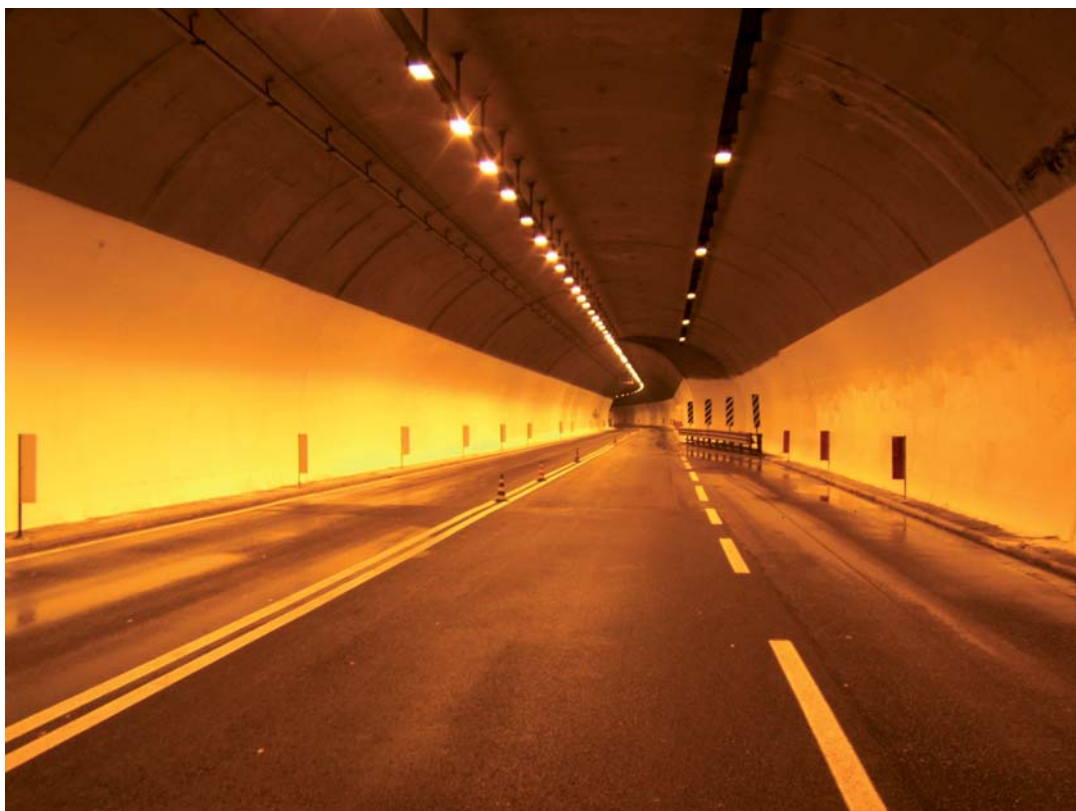
Esecuzione di imbiancatura galleria di nuova apertura al traffico
