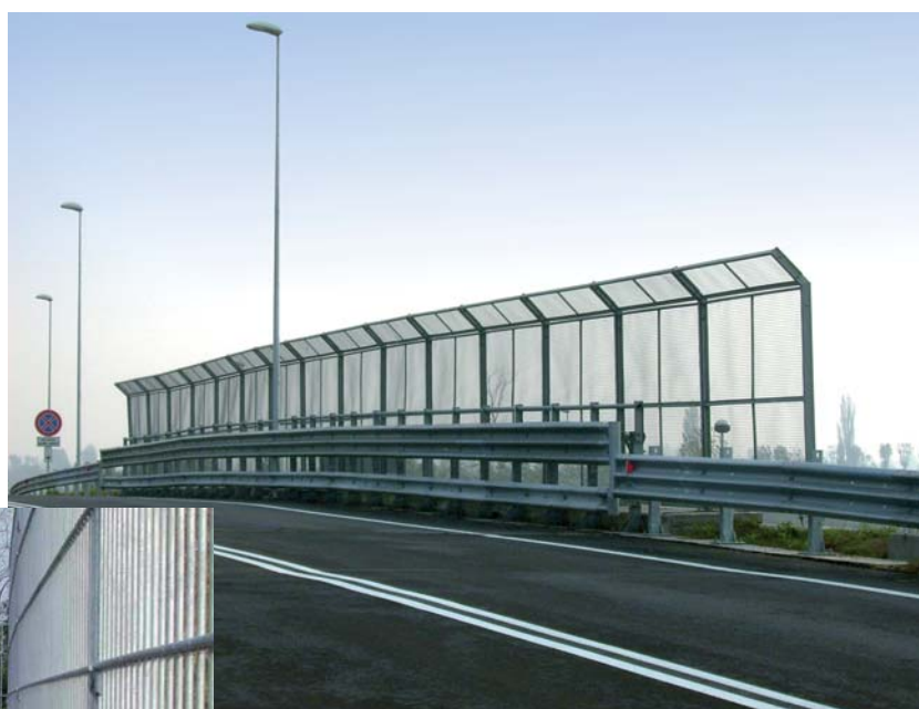
Realizzazione di posa in opera di rete di recinzione ed antisasso su cavalcavia
